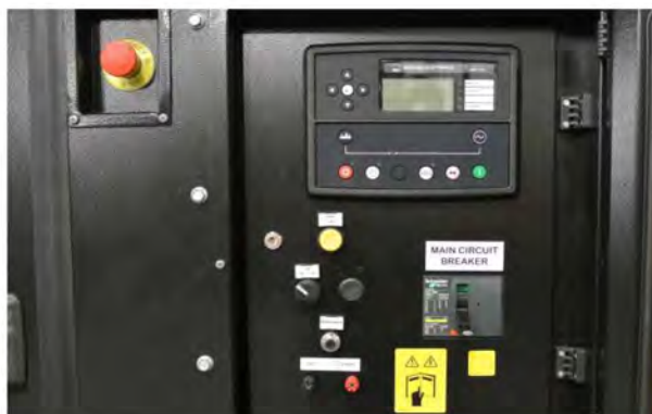
Panel de control, con Deep Sea Controller, diseñado y etiquetado para facilitar su uso. (otras marcas disponibles)
